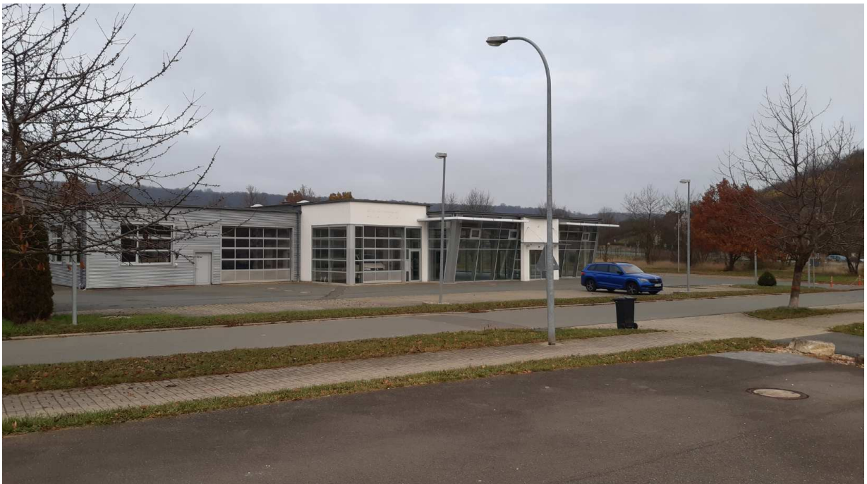
Abbildung: Anlagenstandort mit Bebauung im Bestand aus Richtung Kirschweg
