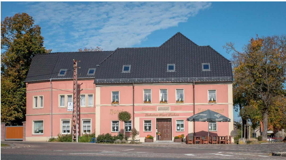
Abbildung 65: Schützenhaus Laucha an der Unstrut - Hotel und Restaurant (Stadt Laucha an der Unstrut o. J. a)
