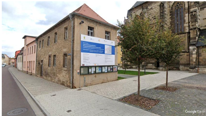
Untere Hauptstraße 2 Quelle: Google Earth Street View 2023
