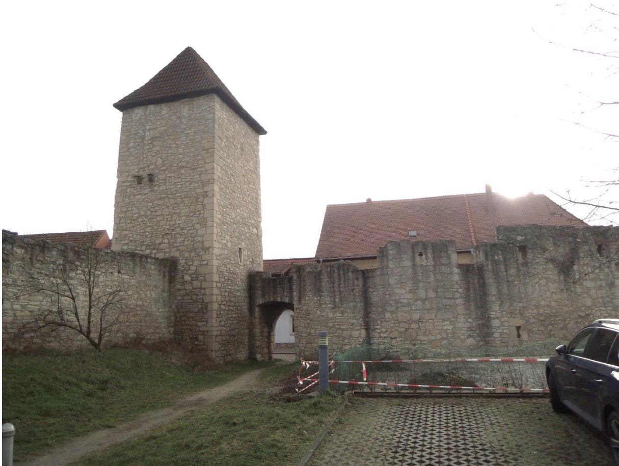
Abbildung 12: Stadtmauer Freyburg (Unstrut) (eigene Aufnahme RoosGrün 2023)
