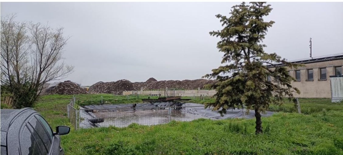
Blick aus Richtung Bürogebäude der BEB in Richtung Deponiekörper/PV-Anlagenstandort
